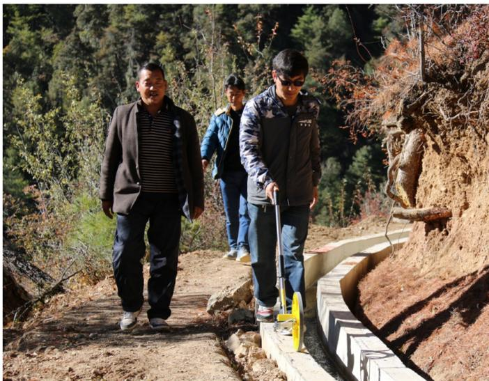
▲因为水务局工作人员利用滚尺测量沟渠长度。日前,德钦县水务局到该县奔子栏镇验收2016年度精准扶贫农田水利和安全饮水巩固提升项目,工作人员参照设计标准,利用滚尺、皮尺等工具对农田水利沟渠的长度、宽度等进行测量,利用回弹仪等工具对混凝土硬度进行测试,对安全饮水项目进行查看、检测,以确定各个项目是否符合建设标准,并针对存在的问题提出整改意见,要求立即整改。据悉,德钦县精准扶贫农田水利灌溉项目共有95件,其中,奔子栏镇42件,该县还将陆续对其他乡镇的精准扶贫水利项目进行验收,确保德钦县精准扶贫水利项目按时按量完成。(王靖萍 摄影报道)
