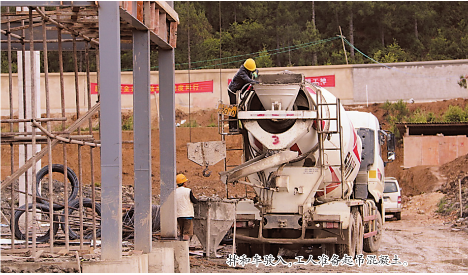
排和车驶入，工人准备起吊混凝土。
