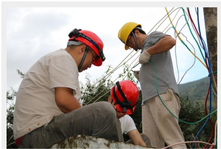
近日,迪庆供电局开发区分局和国电迪庆香格里拉发电有限责任公司赴虎跳峡镇幼儿园开展“金秋乐奉献 迎接十九大”志愿服务活动。来自两家单位的党员、团员青年和员工共25人按照分工,有的爬上楼顶固定线架,有的绑扎敷设线路,有的负责拆除,有的负责接线,有的负责修剪线路周边树枝。经过一天半时间的连续奋战,一条崭新、规范、安全的400伏供电线路全部架设完成。
