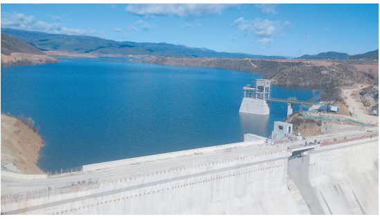
小中甸水库蓄水。
