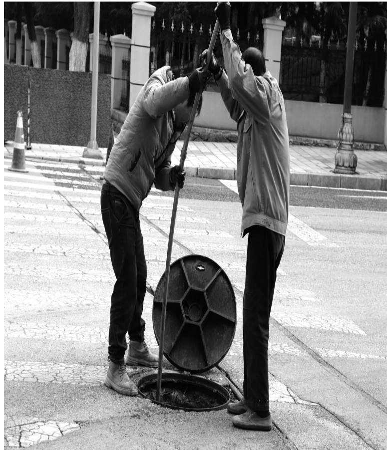
工人正在疏通堵塞的排污井。
